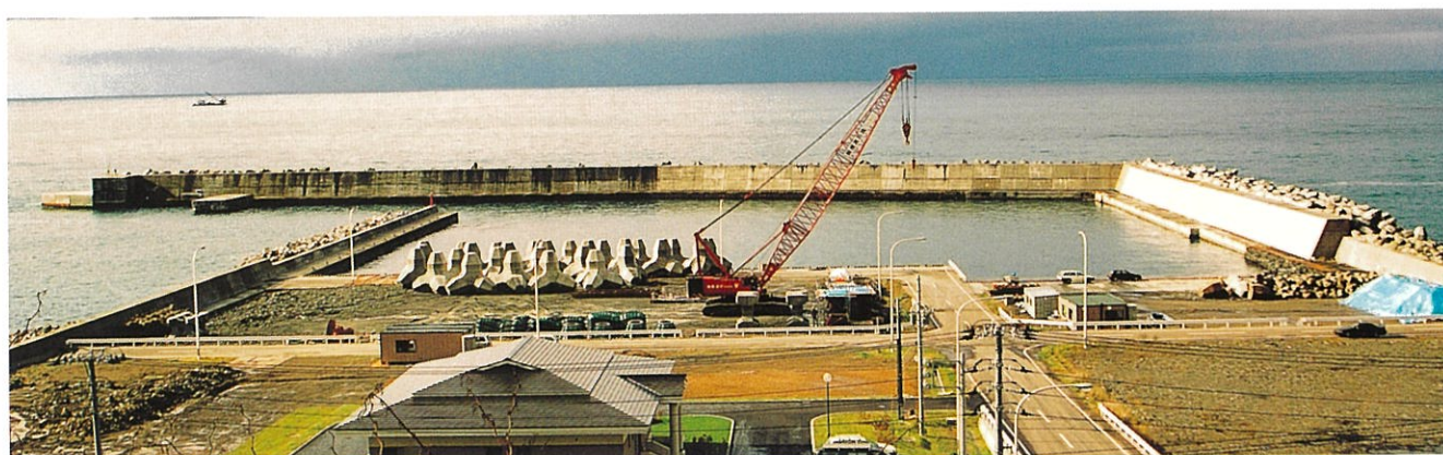
小樽土木現業所 盃漁港(西防波堤60 t 型・80 t 型)
