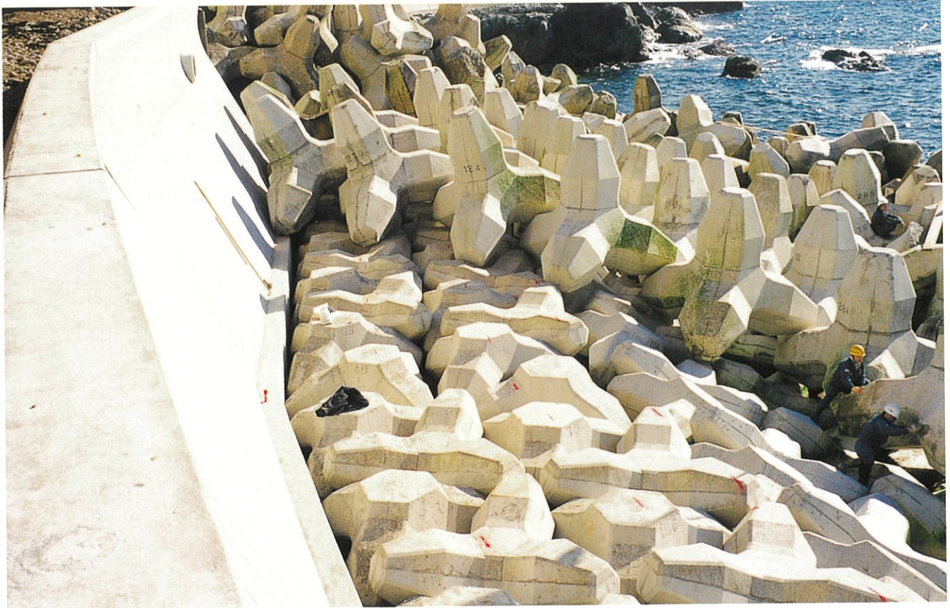
函館開発建設部 北桧山大成線大成町天狗改良 (截頭6.5 t 型)
