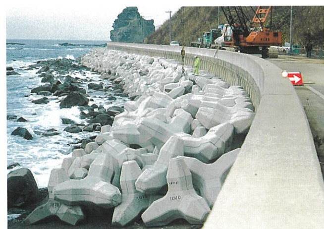
函館土木現業所 奥尻島線湯浜地区(6 t 型)
