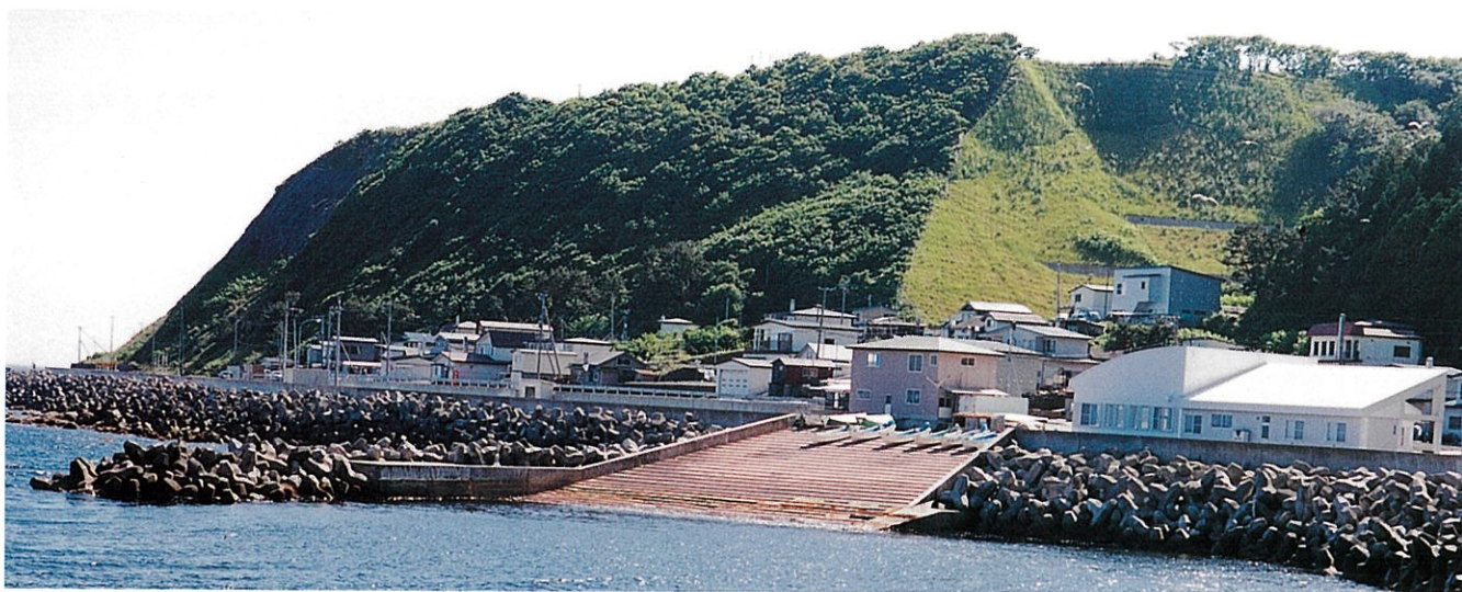
函館土木現業所 元村恵線御崎地区船揚場(8 t 型)
