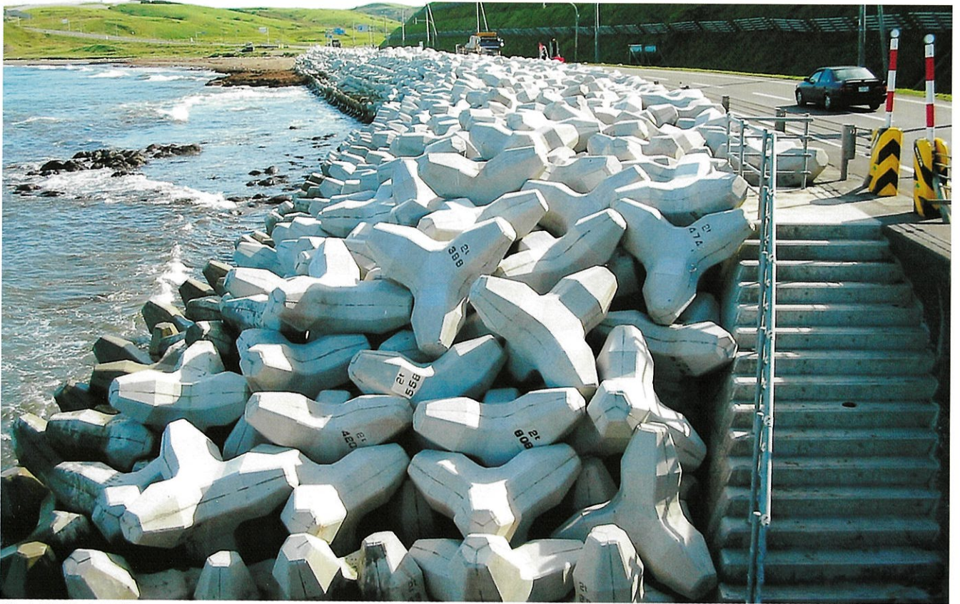
稚内開発建設部 稚内市泊内改良(2 t 型)
