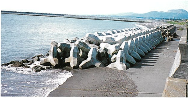
室蘭土木現業所 伊達海岸南稀府地区 (5 t 型)
