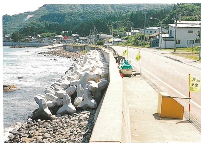
函館土木現業所 奥尻島線球浦地区(3 t 型)
