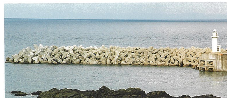
函館土木現業所 豊浜漁港(第2外防波堤60 t 型)
