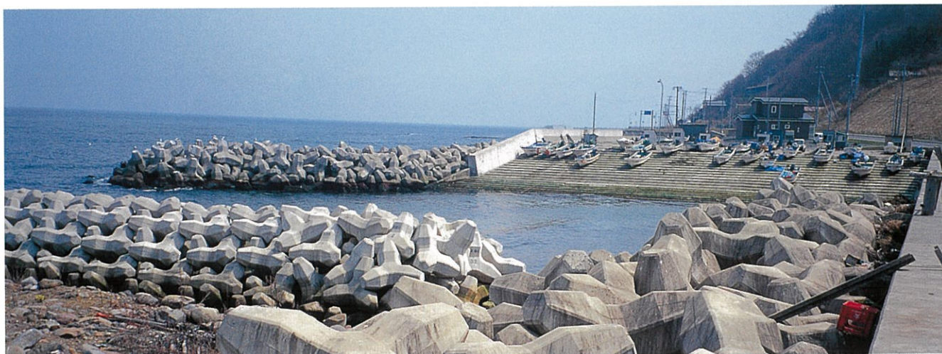
函館開発建設部 南茅部町双見地区船揚場(5 t 型・8 t 型・12 t 型)
