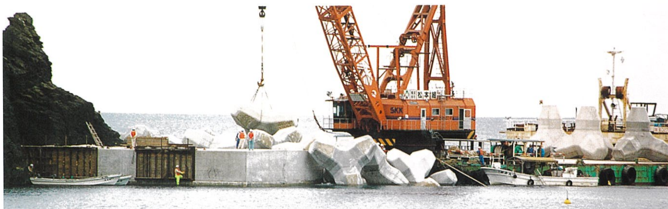
函館土木現業所 中歌漁港(西防波堤80 t 型)
