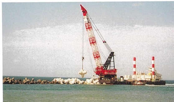
留萌土木現業所 初浦漁港(第2外防波堤80 t 型)
