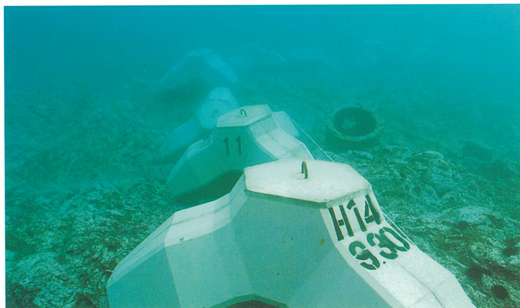
宗谷支庁 礼文船泊地区地域水産物供給基盤上泊増殖場造成工事 (截頭シェークブロックII型(地先型用) 2.5 t 型)
