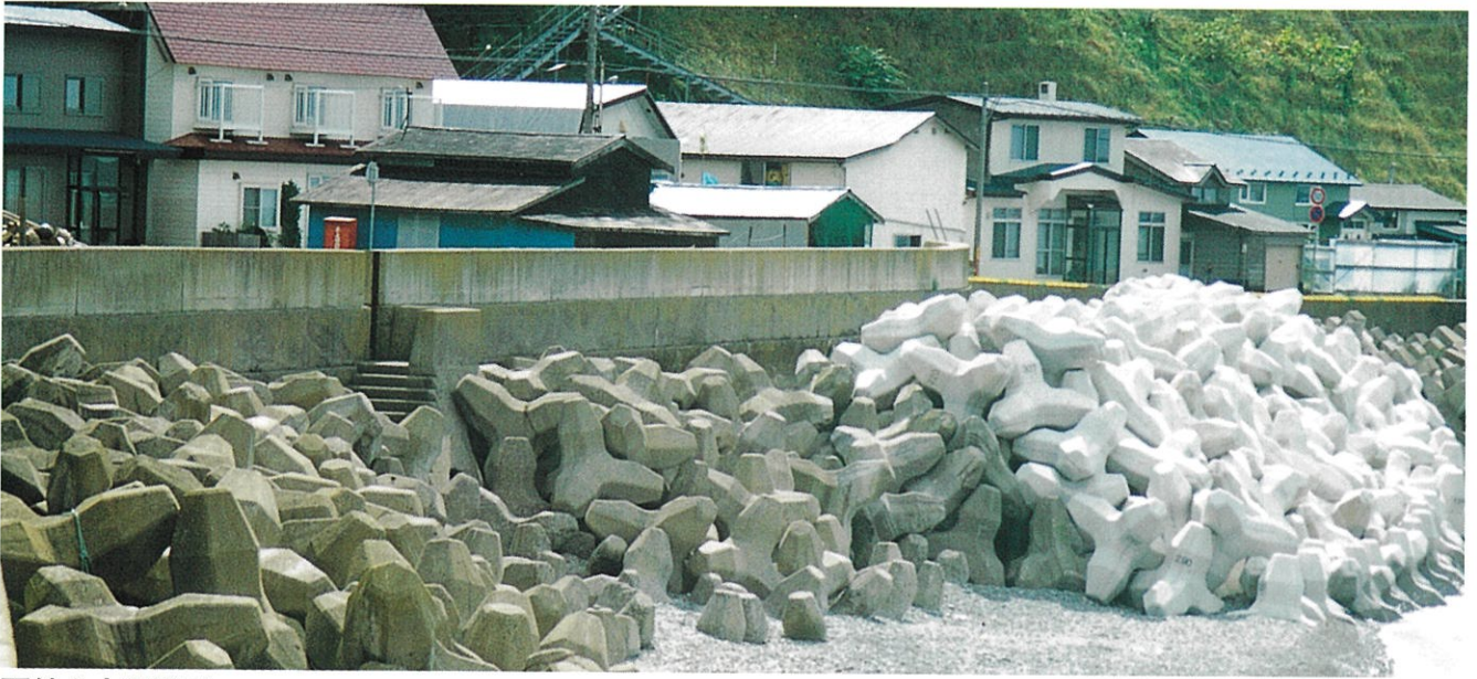
函館土木現業所 熊石町関内海岸(5 t 型)
