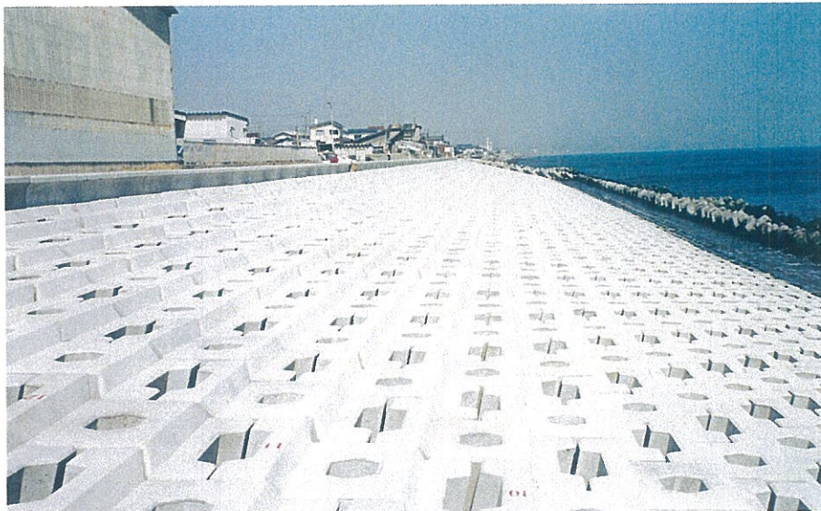
緩傾斜護岸 北海道室蘭土木現業所 登別海岸鷺別地区局部改良工事 サーフブロック2TON型 4割勾配にて施工
