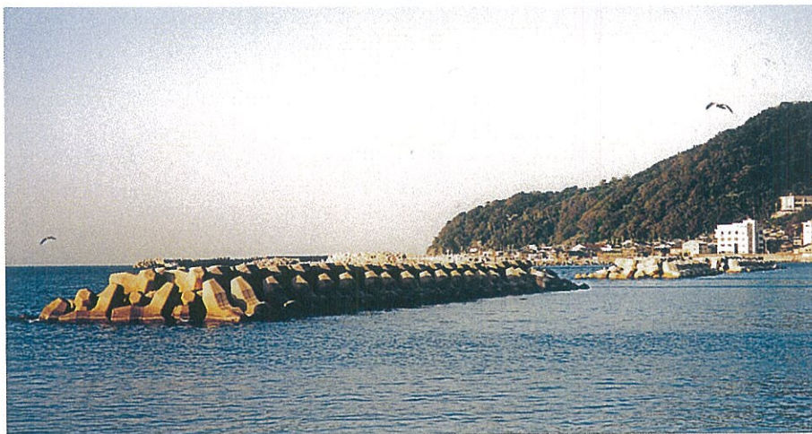
被覆工 福井県丹生耕地事務所 県営越廼海岸環境整備事業 サーフブロック8TON型
