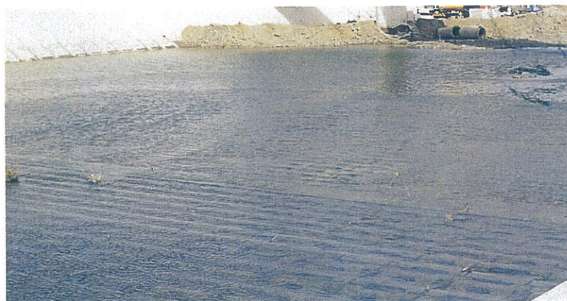
護床工 三重県久居土木事務所 長野川災害復旧助成工事 サーフブロック2TON型 基本1型及び2型併用配列
