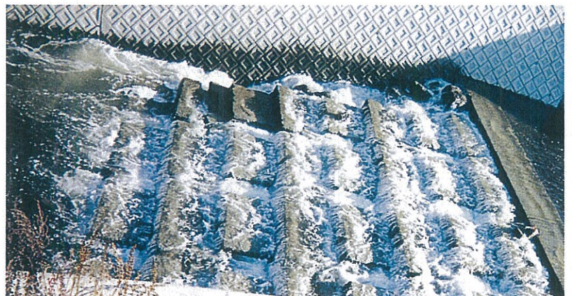
根固工 長野県豊科建設事務所 穂高川国補河川修繕工事 サーフブロック5TON型 基本1型
