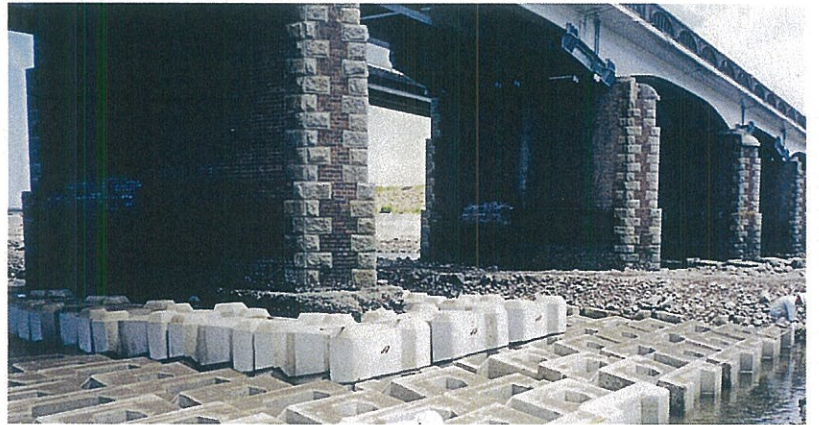
根固工 山梨県葦崎土木事務所 六反川河川災害復旧工事 サーフブロック2TON型 基本1型配列
