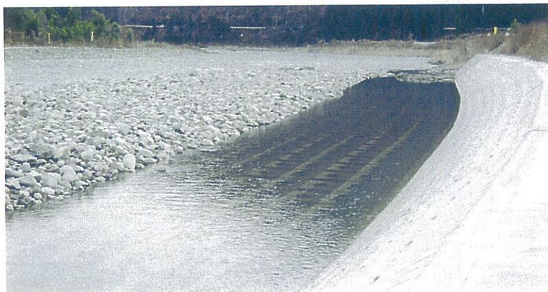
護床工 山梨県菲崎土木事務所 割羽沢川河川改修工事 サーフブロック3TON型 基本2型配列
