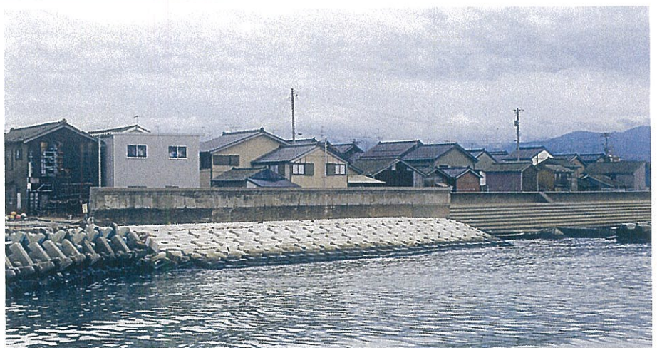
被覆工 富山県入善土木事務所 黒部漁港海岸侵食対策根固工事 サーフブロック2TON型
