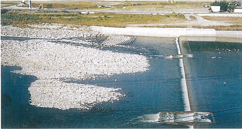
護床工 福井県福井耕地事務所 ため池等整備事業(九頭竜川上志比) サーフブロック4TON型 基本2型配列
