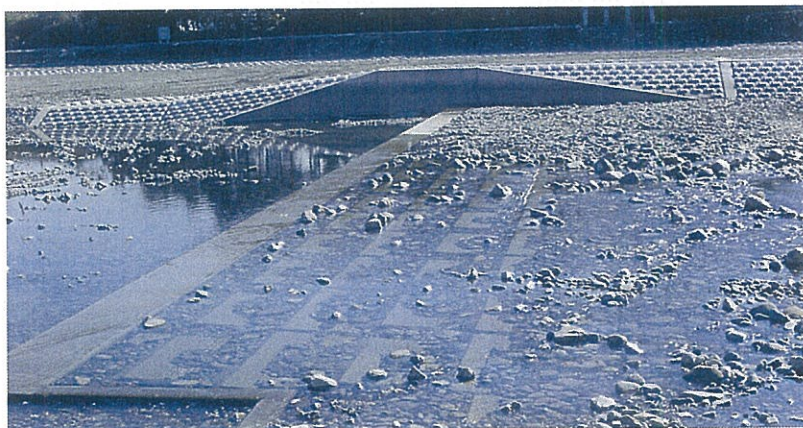
護床工 建設省木曾川上流工事事務所 牧田川応急対策工事 サーフブロック3TON型 基本1型配列
