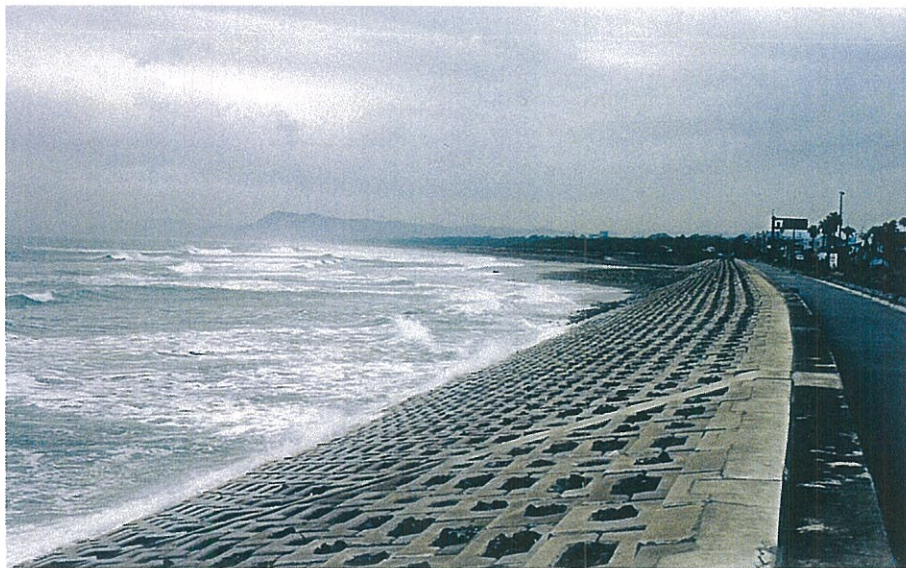
緩傾斜護岸 千葉県鴨川土木事務所 和田白渚海岸高潮対策工事 サーフブロック2TON型 3割勾配にて施工
