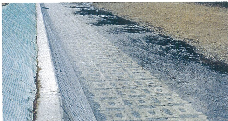
根固工 大分県臼杵土木事務所 臼杵川災害復旧工事 サーフブロック2TON型 基本1型配列
