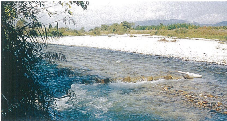
護床工 滋賀県八日市土木事務所 佐久良川災害関連工事 サーフブロック2TON型 基本2型配列
