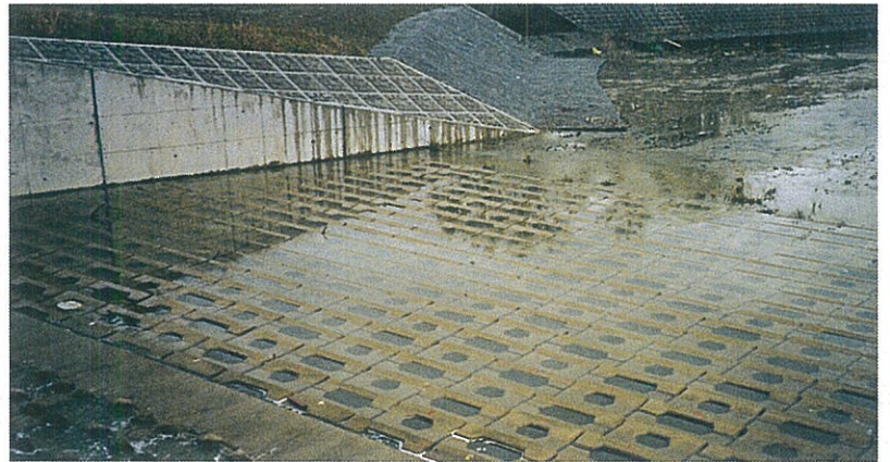
護床工 滋賀県八日市土木事務所 佐久良川災害関連工事 サーフブロック2TON型 基本2型配列
