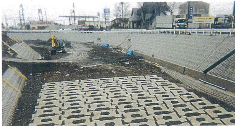
護床工 山梨県菲崎土木事務所 割羽沢川河川改修工事 サーフブロック3TON型 基本2型配列
