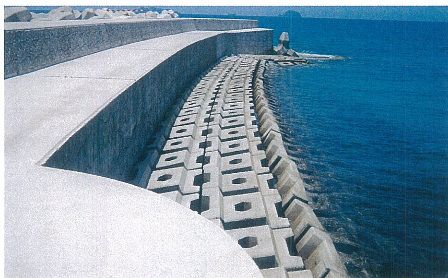
離岸堤（階段工）大分県上浦町役場 福泊漁港海岸保全（高潮対策）工事 サーフブロック4TON型
