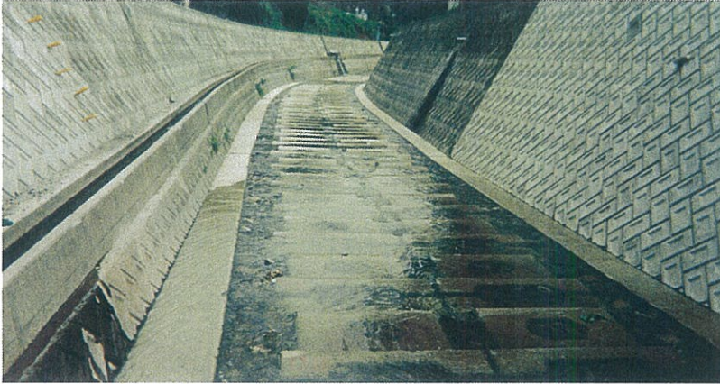
根固工 山梨県葦崎土木事務所 六反川河川災害復旧工事 サーフブロック2TON型 基本1型配列
