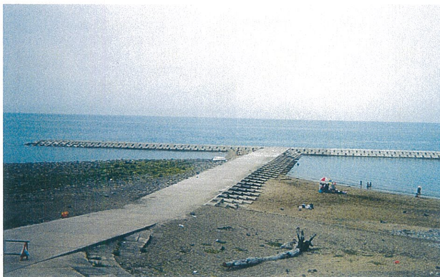
T型突堤工法 島根県益田土木建築事務所 持石海岸環境整備工事 サーフブロック6TON型
