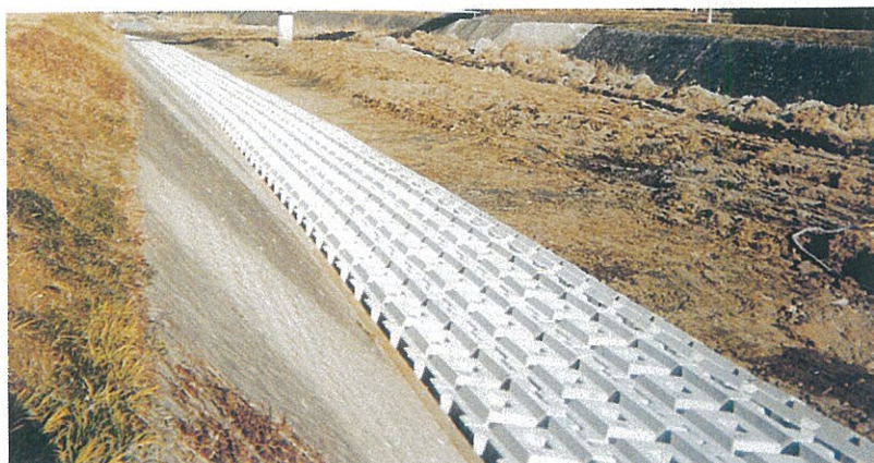
根固工 大分県臼杵土木事務所 臼杵川災害復旧工事 サーフブロック2TON型 基本1型配列
