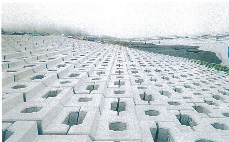
緩傾斜護岸 北海道室蘭土木現業所 荻伏漁港海岸浸食対策工事 サーフブロック2TON型 4割勾配にて施工
