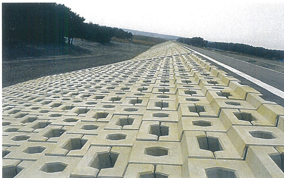
緩傾斜護岸 建設省静岡河川工事事務所 駿河海岸川尻堤防工事 サーフブロック2TON型 3割勾配にて施工
