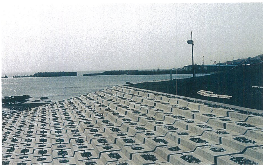
緩傾斜護岸 北海道室蘭土木現業所 えりも海岸えりも岬地区局部改良工事 サーフブロック3TON型 2割勾配にて施工
