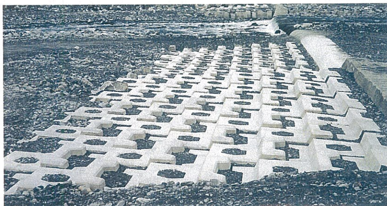
護床工 静岡土木事務所 安倍川維持修繕工事 サーフブロック12TON型 基本2型配列 (2段積み)
