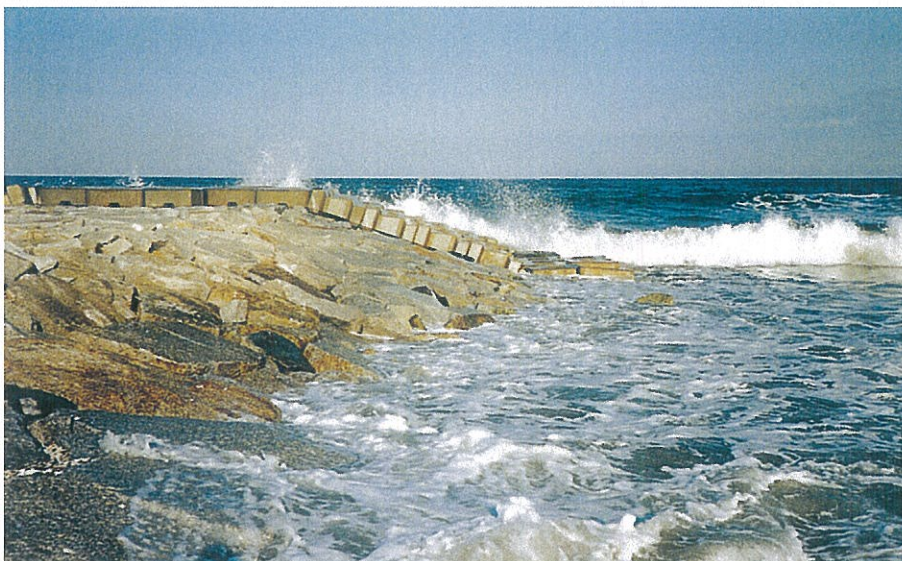
被覆工（ヘッドランド） 茨城県潮来土木事務所 鹿島海岸侵食対策工事 サーフブロック2TON型
