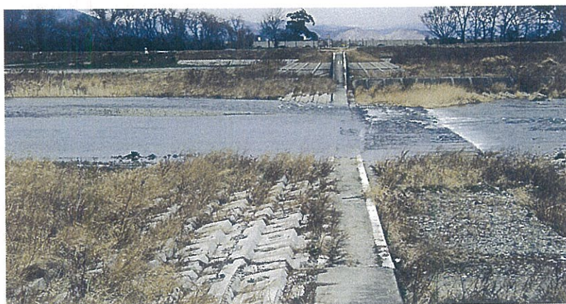
根固工 岐阜県揖斐土木事務所 根尾川災害復旧工事 サーフブロック5TON型 基本1型配列
