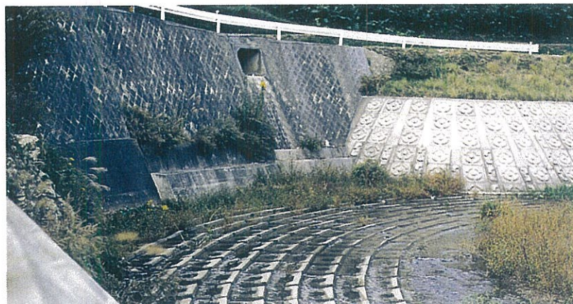
根固工 三重県伊勢土木事務所 伊勢路川災害関連工事 サーフブロック2TON型 基本1型配列
