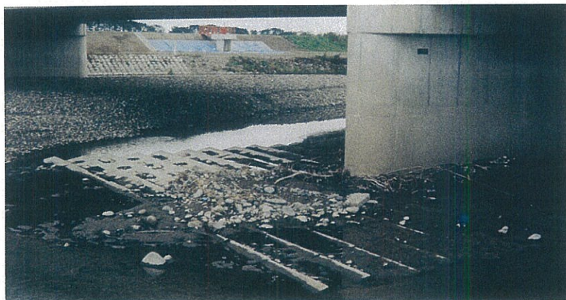
護床工 静岡土木事務所 安倍川維持修繕工事 サーフブロック12TON型 基本2型配列 (2段積み)
