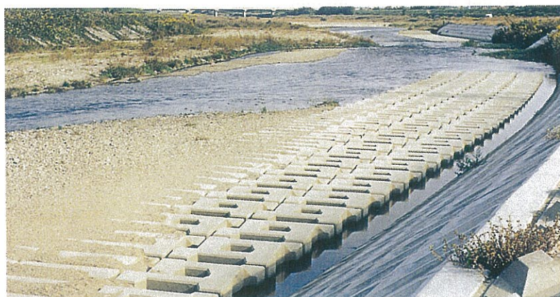
根固工 三重県伊勢土木事務所 伊勢路川災害関連工事 サーフブロック2TON型 基本1型配列
