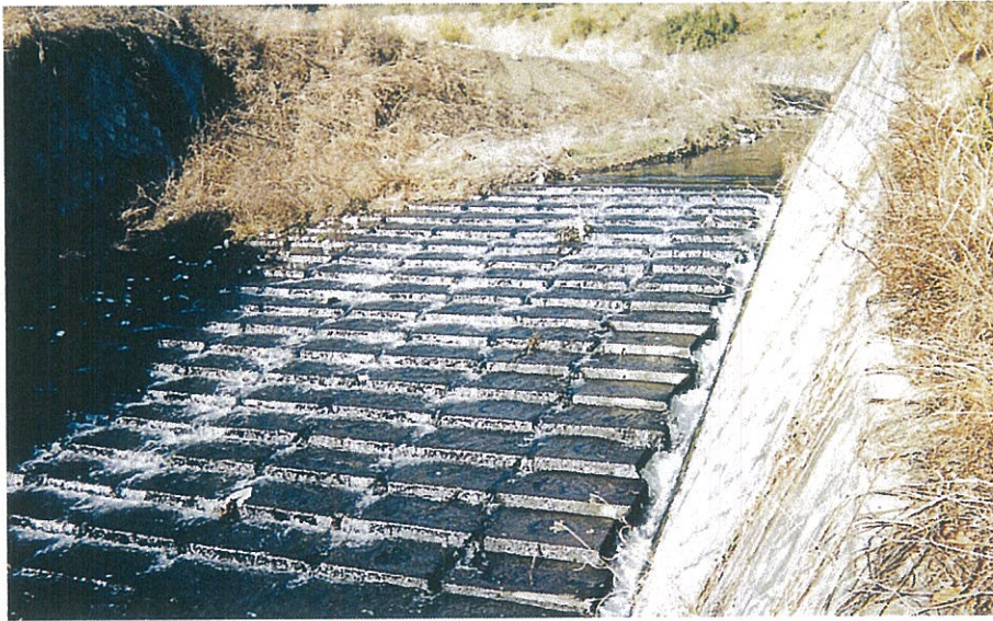
護床工 静岡県富士土木事務所 足取川河川改良工事 サーフブロック2TON型 基本2型配列
