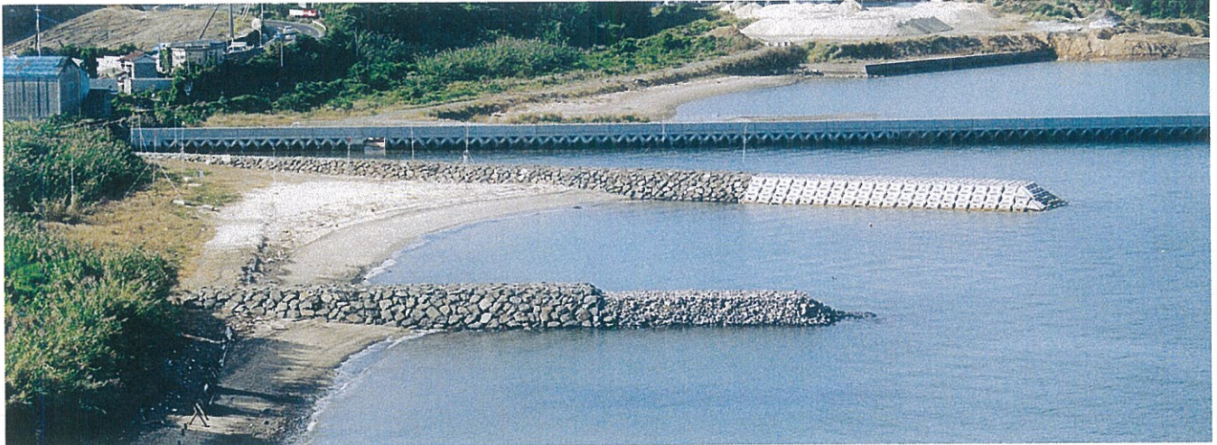
被覆工（突堤工法）長崎県田平土木事務所 調川港海岸局部改良工事 サーフブロック2TON型
