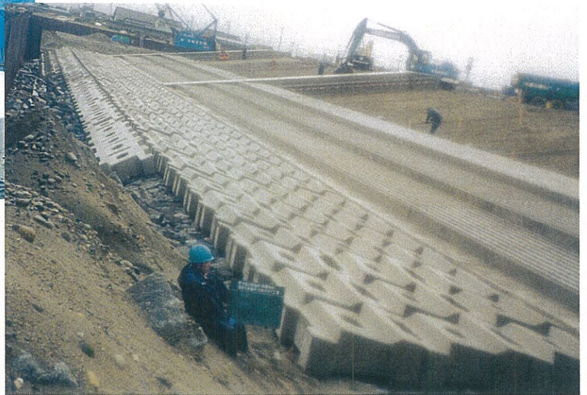
根固工 富山県高岡土木事務所 伏木富山港（新湊地区） 侵食対策工事 サーフブロック2TON型
