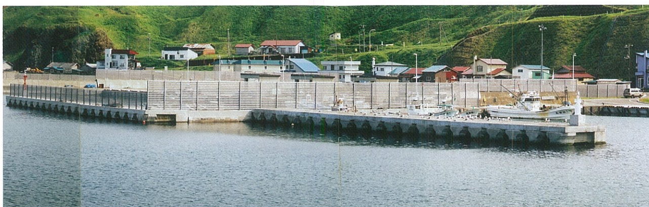
北海道須古頓漁港(港内突堤)
