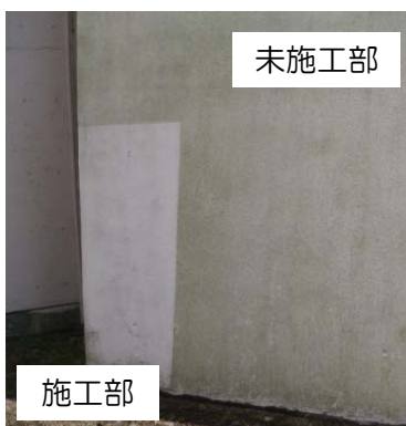
下地：吹付けタイル
